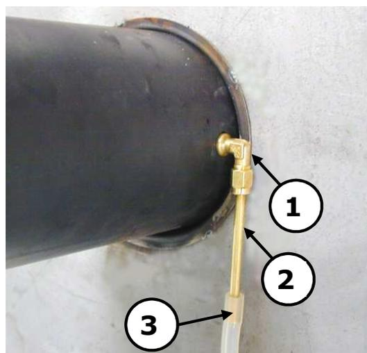
Abb. 5: Druckmessadapter installiert
